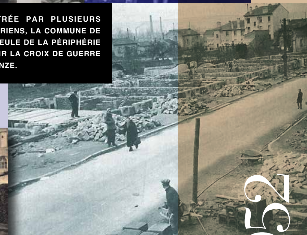
Travaux de reconstruction d'après-guerre, Avenue de la République
